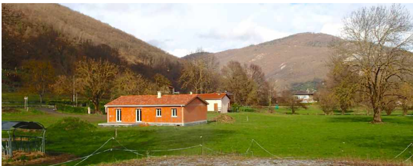
Constructions récentes à Sainte-Marie
