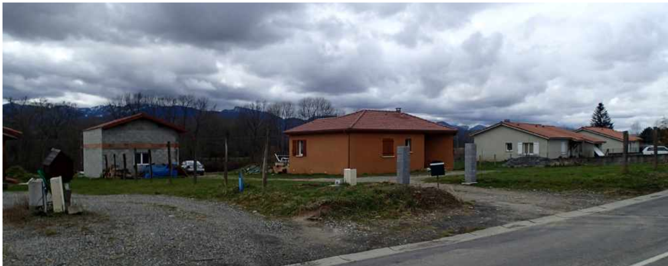
Constructions récentes à Saint-Paul de Neste
