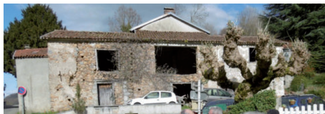
Du bâti en ruine qui pénalise la perception des centres bourgs (Bas-Nistos / Seich)
