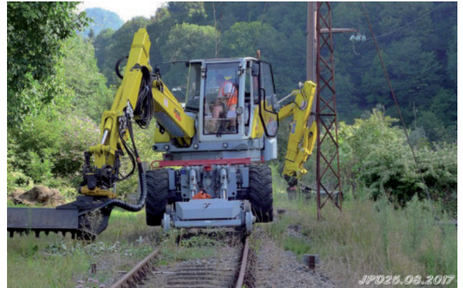
Remise en fonction de la ligne Montréjeau / Luchon avec un train à hydrogène.
